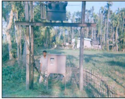
आकृति 3.4 : एस पी एस एस तंत्र के अंतर्गत ट्रंसफार्मर पर संस्थापित विद्युत मीटर
