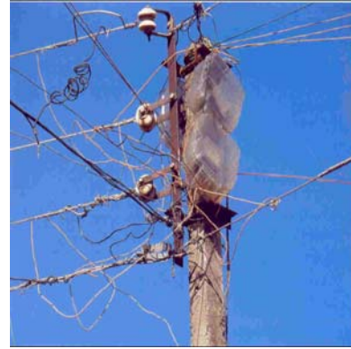
आकृति 2.3 पोल पर मीटर (चोरी रोकने के लिए)
