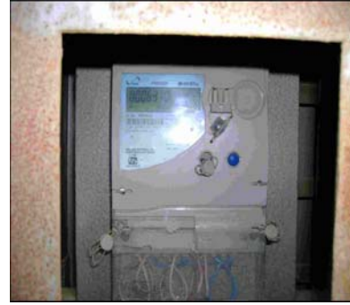
आकृति 3.4 : एस पी एस एस तंत्र के अंतर्गत ट्रंसफार्मर पर संस्थापित विद्युत मीटर
